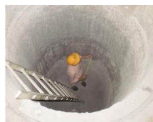
Ispezione dopo 6 mesi di esercizio del CPS® da 13,5 t.
